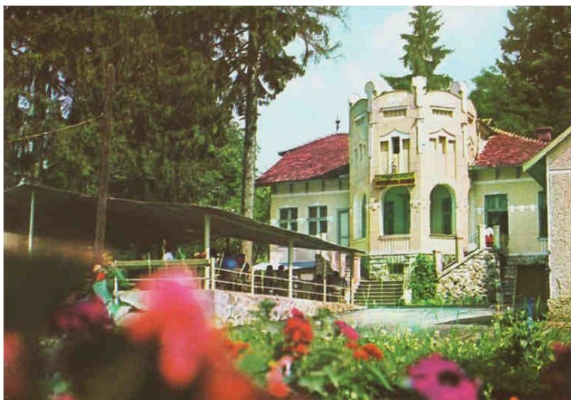
Restaurantul „Izvorul Roșu”
